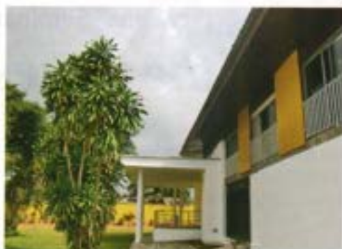
Le siège de l'ARA à Abidjan ARA head office in Abidjan
