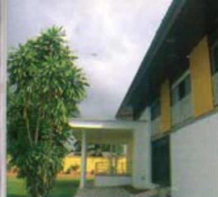
Le siège social de l'ARA à Abidjan The ARA head office in Abidjan
